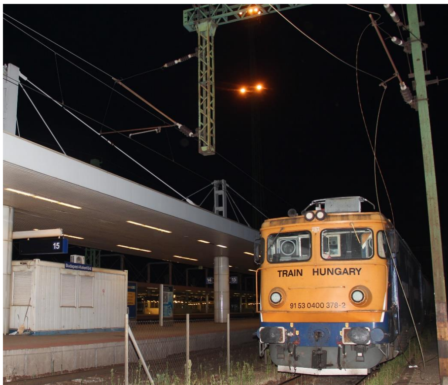
2. kép: Rongálódásos vasúti baleset Budapest-Kelenföld állomáson 2024.07.29.
